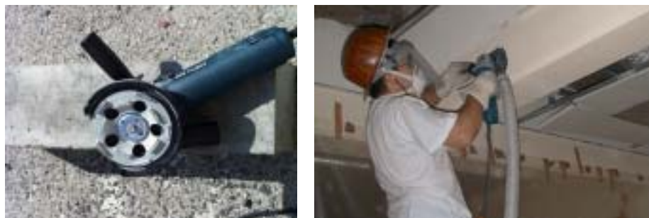
Figura 2: Equipamento para desbaste superficial
