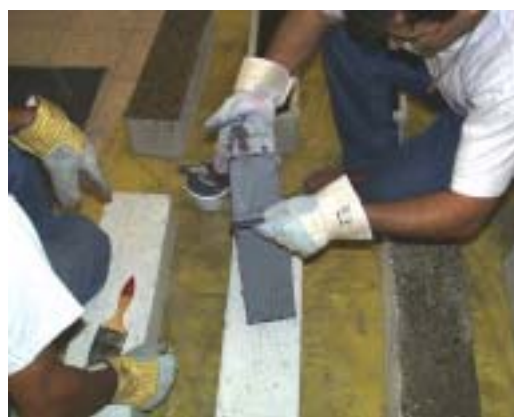
Figura 5: Remoção do adesivo em excesso com auxílio de uma régua dentada
