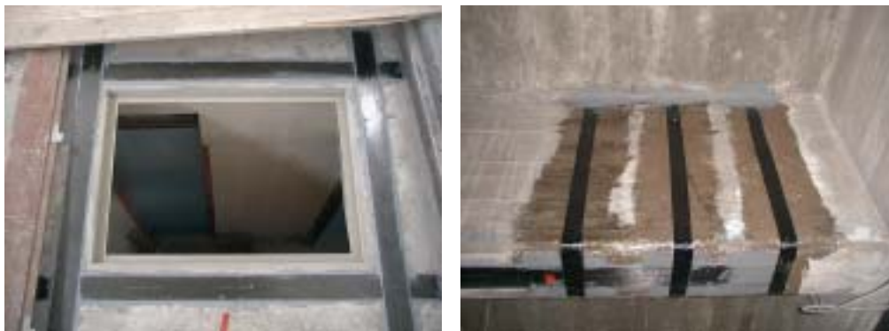
Figura 1: Reforço de elementos de betão armado pela adição de compósitos CFRP nas formas de laminado e de folha
