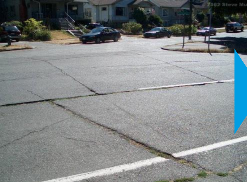
Fissuras na superfície
