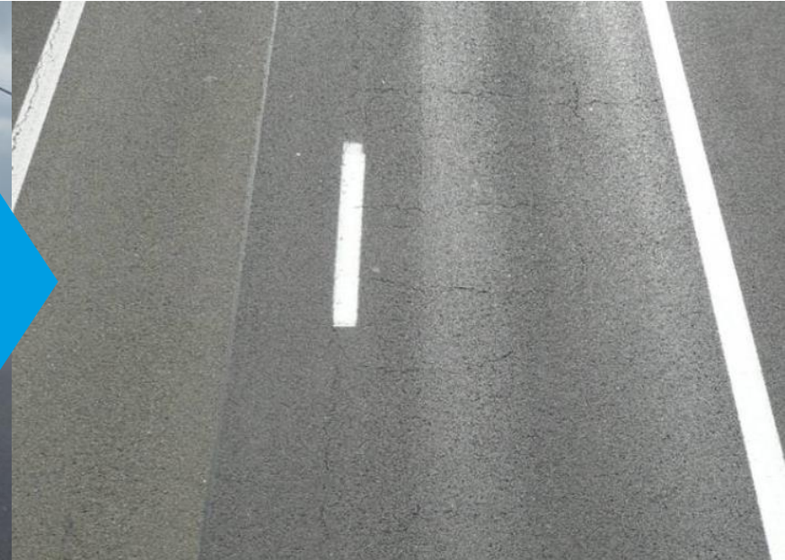
Fissuras reflexivas de debaixo da estrutura através da superfície de asfalto.
