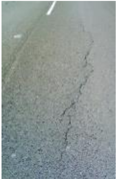
Fissuras de reflexão
