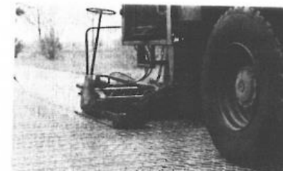
Het plaatsen van de slemlaag gaat zeer vlug ...
