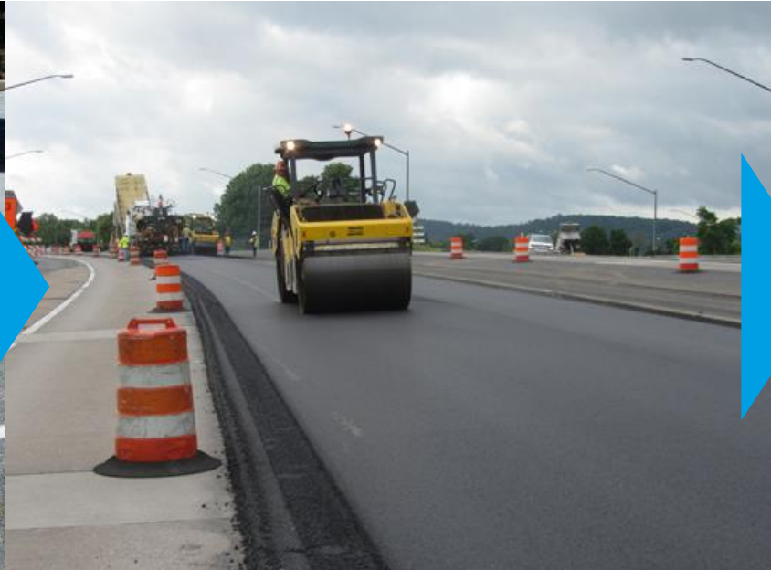
Camada de sobreposição de asfalto sem camada intermédia de prevenção de fissuração.
