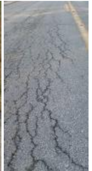
Fissuração por fadiga
