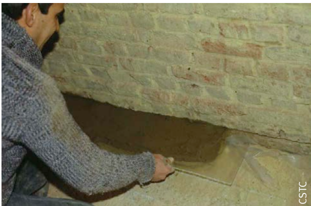
Fig. 47 Insertion d'une membrane semi-rigide, préalablement enduite de mortier, dans la saignée.
