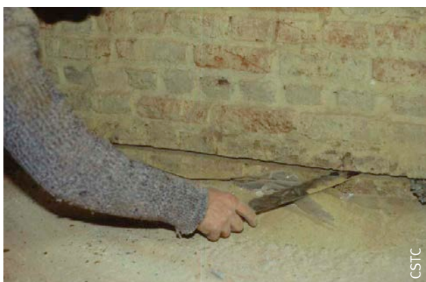
Fig. 46 Dégagement de la saignée.
