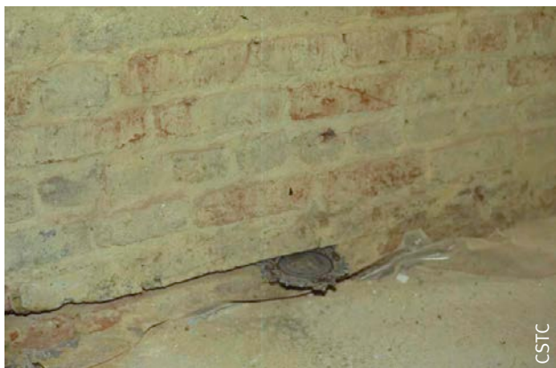
Fig. 45 Réalisation d'une saignée horizontale dans la maçonnerie.
