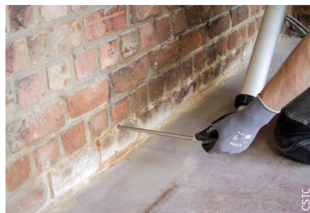
Fig. 56 Injection d'un produit hydrophobe sous forme de crème ou de gel.
