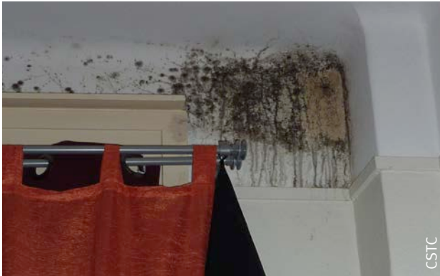
Fig. 25 Développement de moisissures dans les angles et les espaces confinés.
