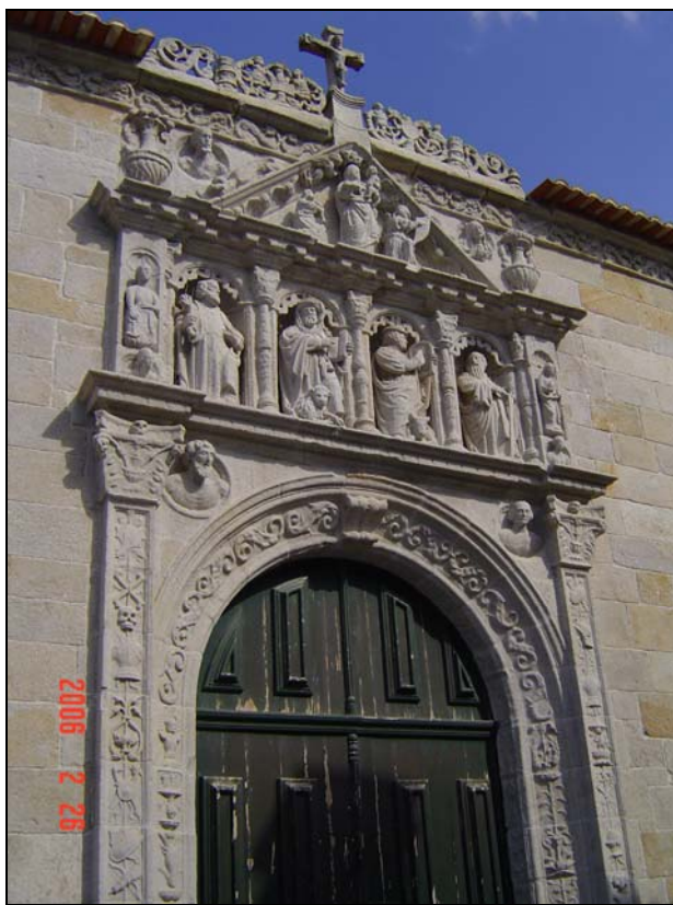
Figura 1.14 Aspecto do portal Sul da Igreja Matriz de Caminha (Fevereiro de 2006).
