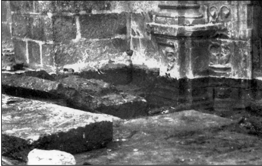
Figura 1.12 Portal principal – Área que se encontrava soterrada. Trabalhos realizados pela DGEMN na década de 30 do século XX. (Direcção Geral dos Edifícios e Monumentos Nacionais, 1936).
