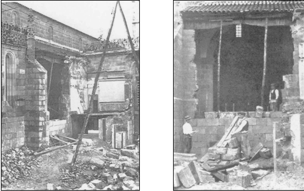
Figura 1.9 Demolição de um pequeno edifício acrescentado à capela do Bom Jesus dos Mareantes. Trabalhos realizados pela DGEMN na década de 30 do século XX. (Direcção Geral dos Edifícios e Monumentos Nacionais, 1936).
