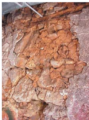
Figura 1 – Dois exemplos de paredes de alvenaria de pedra irregular, com juntas preenchidas de barro e cal
