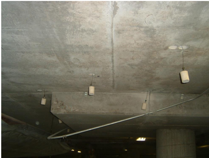
Ânodos durante a instalação
